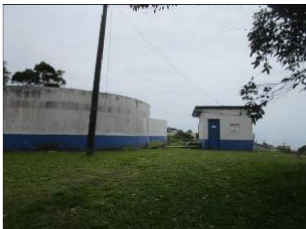
Figura 35: Vista da ERAT 04, junto ao reservatório R1 no Centro de Controle Operacional.
