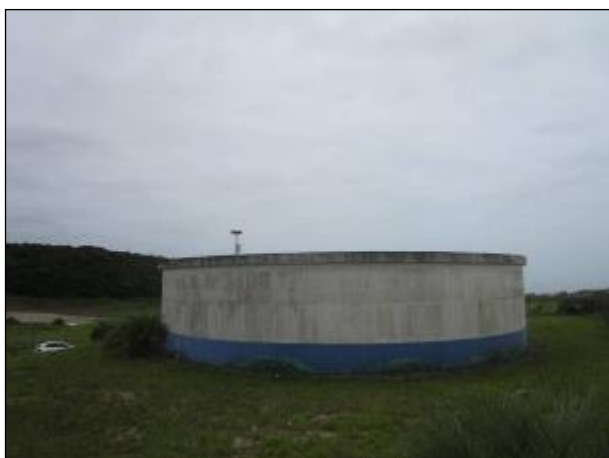
Figura 81: Vista do reservatório R6, boas condições.
