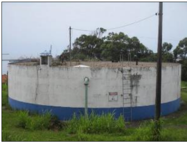
Figura 65: Vista do reservatório R2, incluindo sua parte superior, em bom estado.
