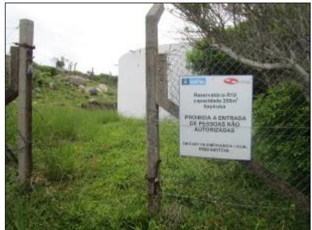
Figura 104: Vista da entrada da unidade, sem o portão para o fechamento adequado e inibição do acesso ao reservatório R10.
