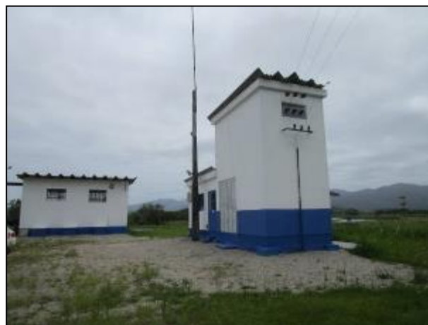
Figura 2: Vista da área interna da Área de Captação e as construções que abrigam as bombas de recalque de água bruta, ao fundo, e a estrutura de comando e abrigo para o operador, à direita.
