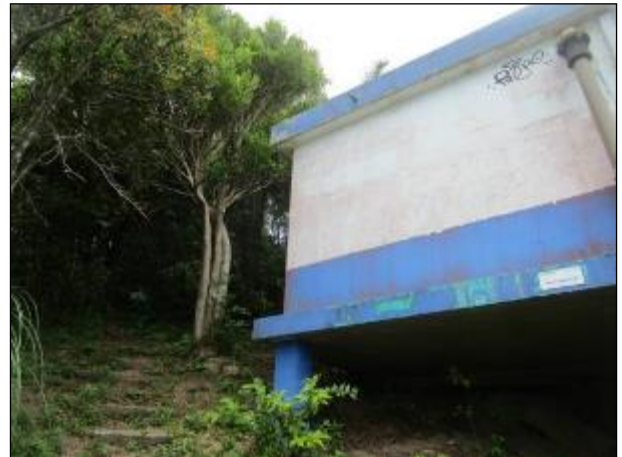
Figura 92: Parte da estrutura do reservatório R8 em boas condições estruturais.
