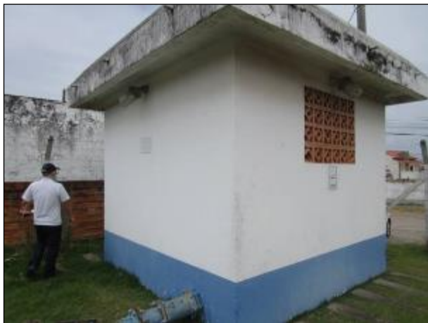
Figura 59: Vista da edificação em boas condições estruturais.
