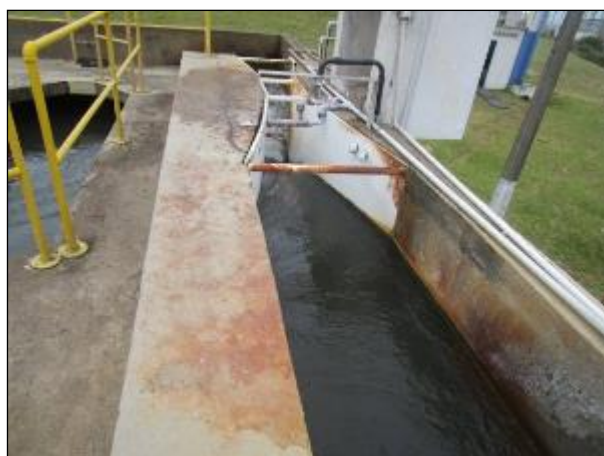
Figura 20: Entrada da água bruta no tratamento.
