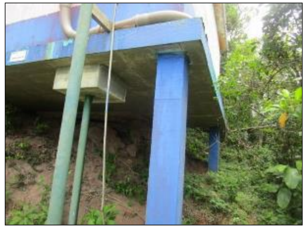
Figura 90: Parte da estrutura do reservatório R8 em boas condições estruturais.
