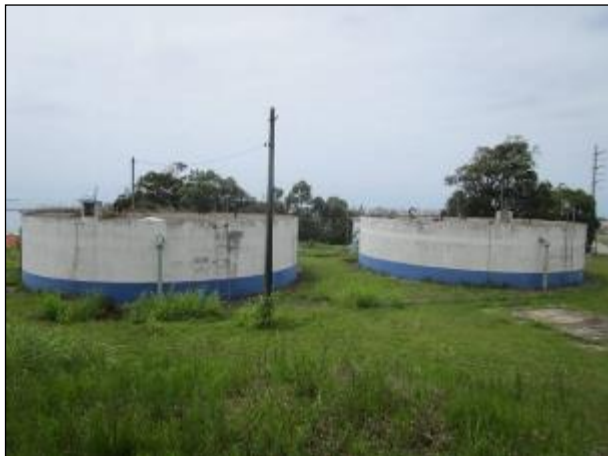
Figura 61: Vista da área do CCO onde estão localizados os Reservatórios R1 (direita) e R2 (esquerda).
