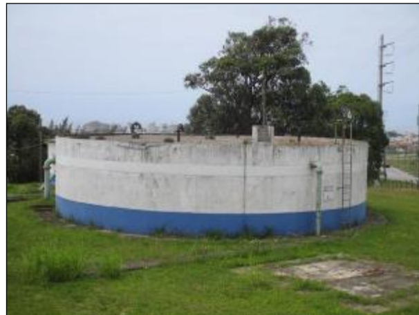
Figura 62: Vista do reservatório R1, incluindo sua parte superior, em bom estado. Sem identificação.
