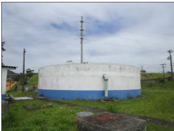
Figura 63: Vista do reservatório R1 com seu extravasor e junto à ERAT 04.
