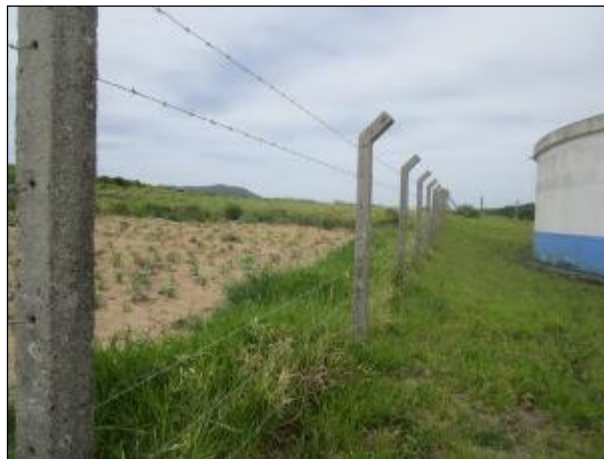
Figura 78: Cercamento no terreno do reservatório R6.
