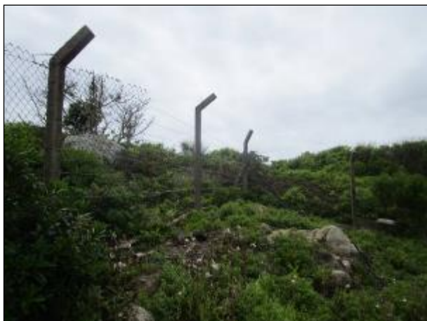
Figura 105: Vista do cercamento da unidade no setor de fundos do terreno.
