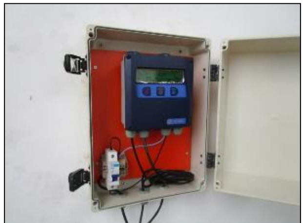
Figura 10: Aparelho controlador de condutividade instalado junto à Captação rio D'Una. Seu acompanhamento é feito remotamente na ETA Nova Brasília.
