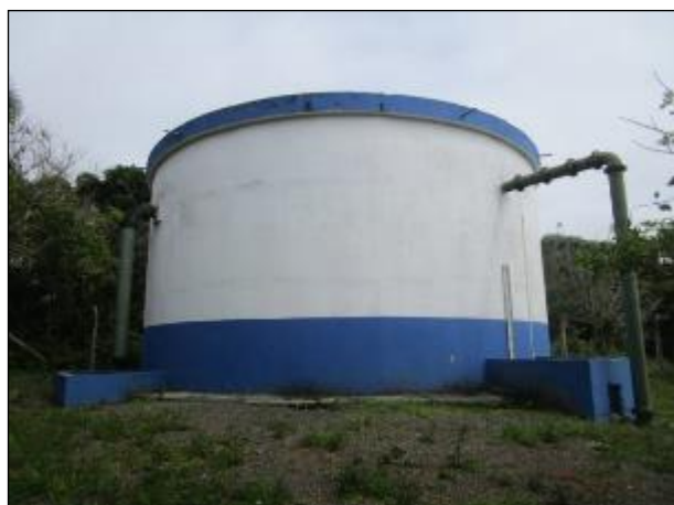
Figura 99: Vista do reservatório R9, boas condições de manutenção estrutural.
