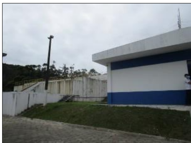
Figura 19: Vista de parte do prédio de apoio das operações e da área de tratamento da ETA Nova Brasília (à esquerda).
