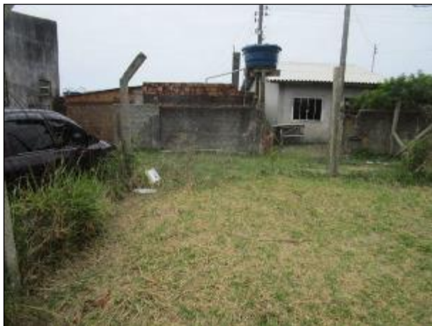
Figura 71: Vista dos fundos do terreno onde está localizada a unidade reservatório R4, cercamento em condições satisfatórias.
