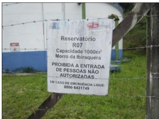
Figura 83: Placa indicativa do reservatório R7, localizado no bairro Ibiraquera.
