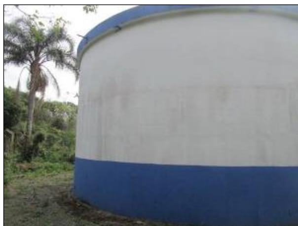
Figura 100: Vista do reservatório R9, boas condições de manutenção estrutural.
