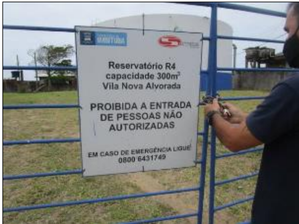
Figura 69: Vista em detalhe da placa indicativa da unidade reservatório R4.
