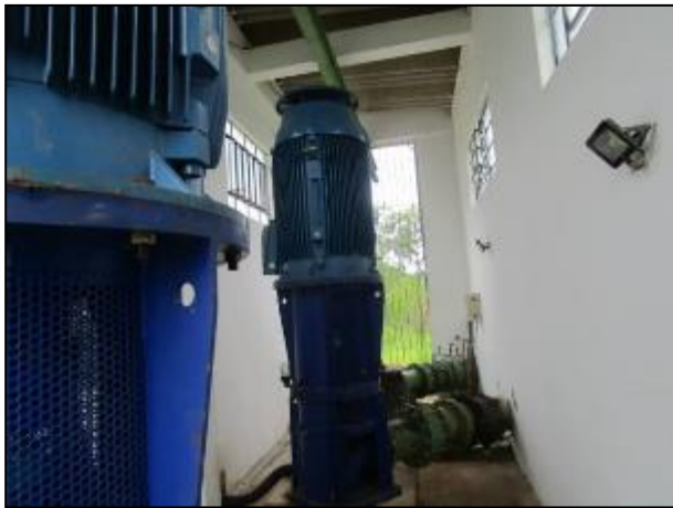
Figura 7: Vista da ERAB com duas novas bombas, incluindo novos motores.
