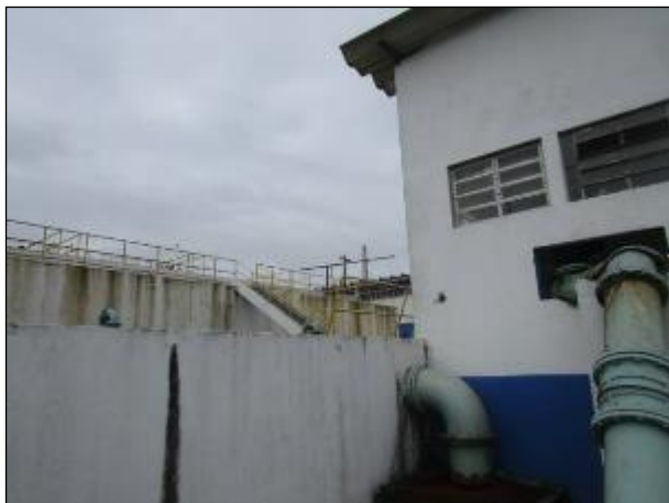
Figura 27: Vista de parte da adutora de água tratada em bom estado (à direita) e a lateral do reservatório R5A à esquerda (próximo) em condições satisfatórias.
