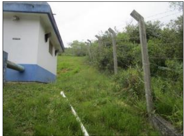
Figura 44: Vista de parte da edificação e do cercamento da unidade, ambos em condições satisfatórias.
