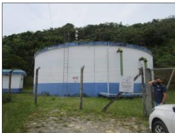
Figura 84: Vista do reservatório R7, cercamento e portão em condições satisfatórias.
