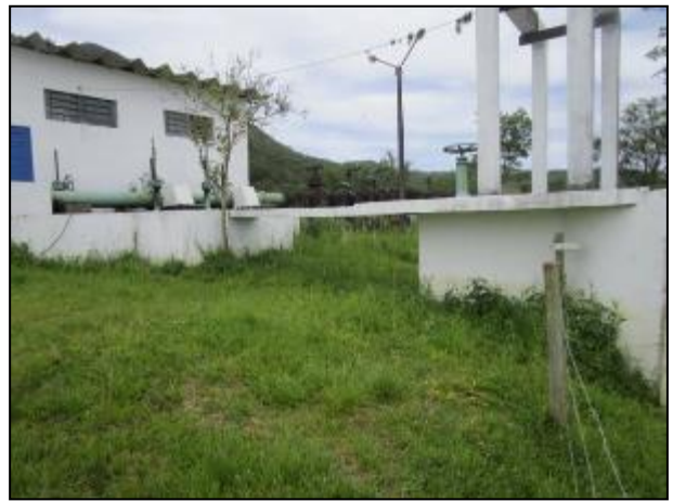
Figura 6: Vista da edificação onde estão instaladas as bombas da ERAB, junto à Captação, à esquerda.
