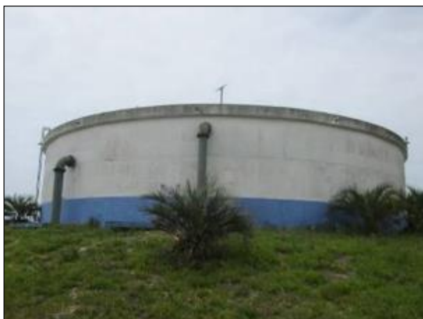
Figura 79: Vista do reservatório R6, boas condições.
