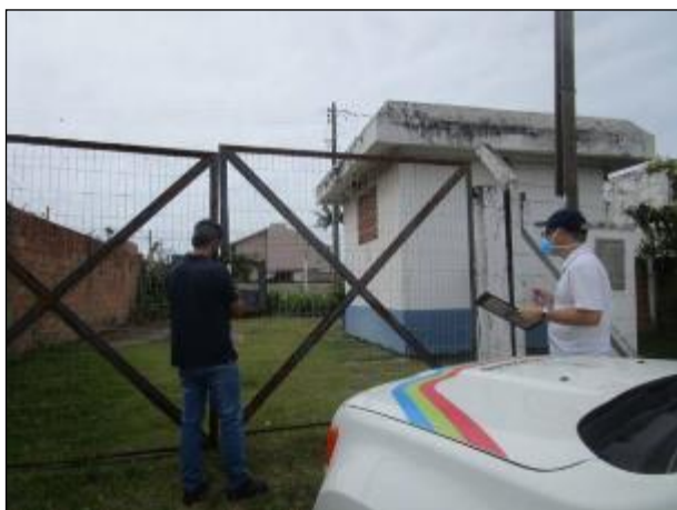
Figura 57: Entrada da unidade de recalque de água tratada denominada ERAT 09, sem placa indicativa disponível.
