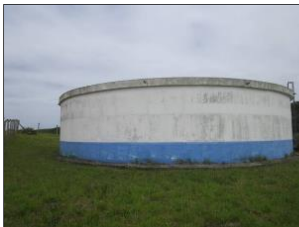
Figura 80: Vista do reservatório R6, boas condições.
