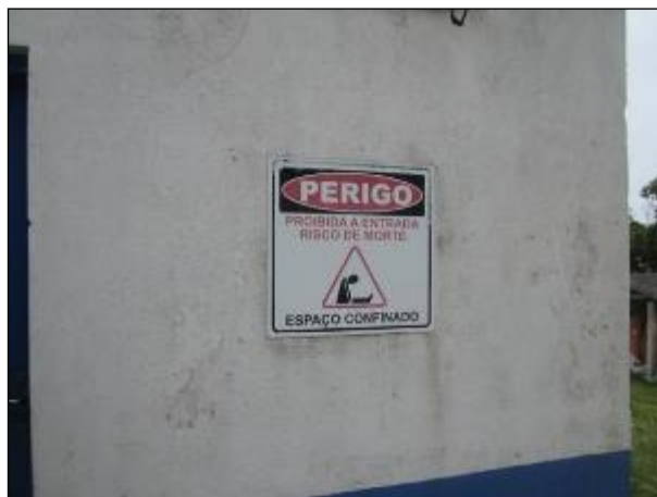
Figura 36: Placa afixada na entrada da unidade de recalque da água tratada ERAT 04.
