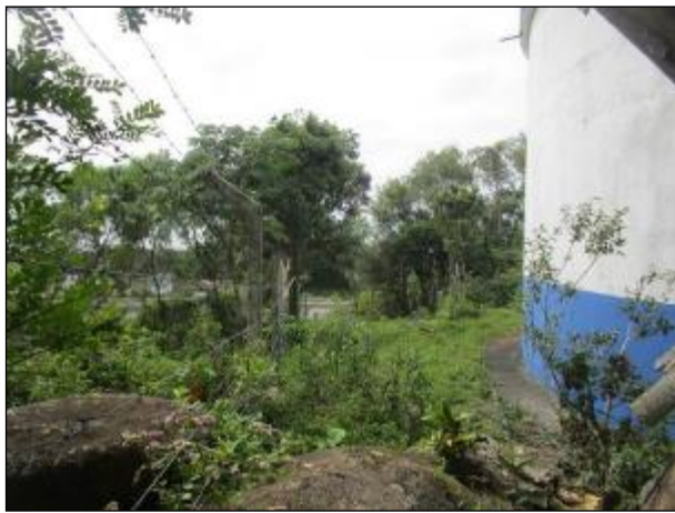
Figura 101: Vista do cercamento em boas condições na lateral do terreno.
