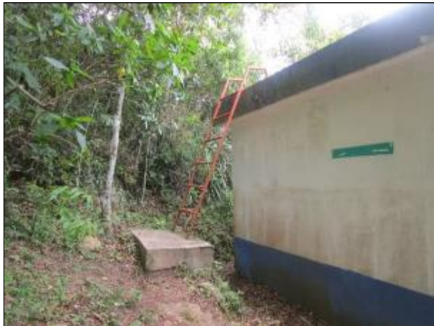
Figura 91: Vista da escada de acesso à parte superior da unidade, boas condições.
