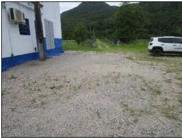
Figura 13: Vista do pátio do local, com o piso natural recoberto por pedra brita para evitar problemas na locomoção em período de chuvas.
