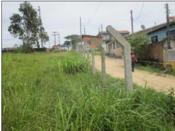
Figura 67: Vista de área lateral do CCO, onde é possível ver o cercamento do terreno em bom estado.
