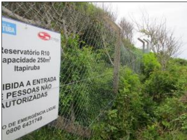
Figura 103: Vista da placa indicativa da unidade reservatório R10 e cercamento com nova estrutura.
