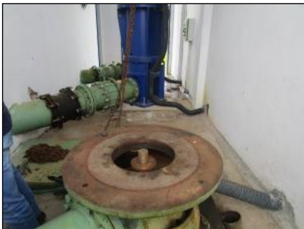
Figura 9: Vista em detalhe do local onde o motor foi retirado para ser feita a reforma.
