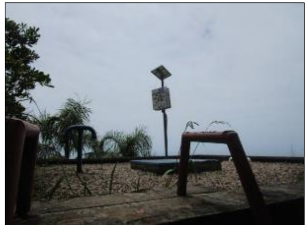
Figura 94: Vista em detalhe de parte do topo do reservatório R8, destaque para o equipamento transmissor dos dados para monitoramento da unidade
