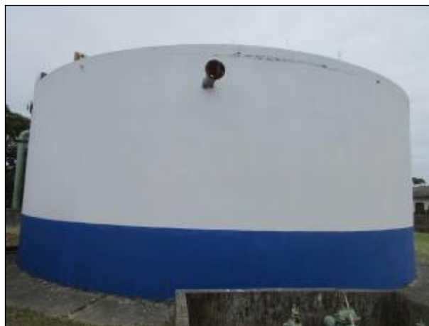
Figura 74: Vista da unidade R4, boas condições de manutenção de sua estrutura.
