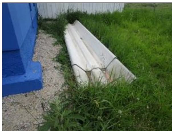
Figura 18: Cobertura a ser instalada na edificação disposta em local próximo a esta. Previsão de instalação para o ano de 2022.
