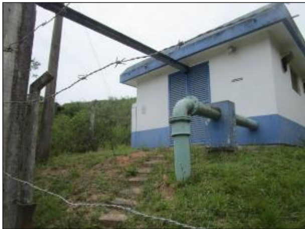
Figura 43: Vista da tubulação de entrada da água tratada na unidade ERAT 07 e estrutura da edificação em condições satisfatórias.
