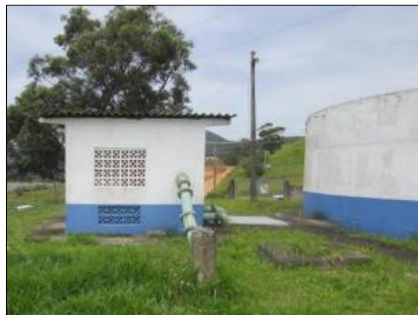
Figura 64: Vista do reservatório R1 (direita) e da ERAT 04 (esquerda).
