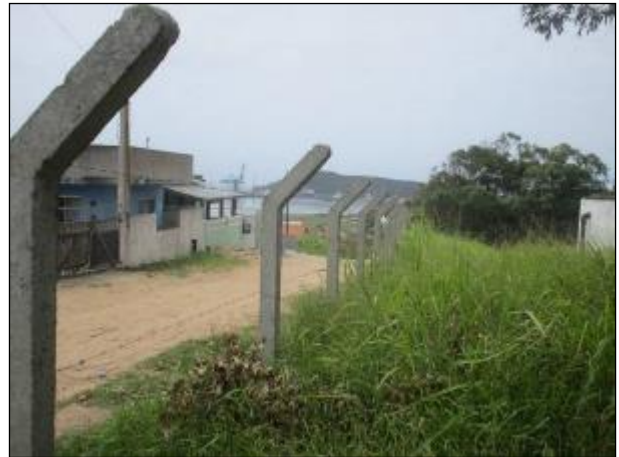
Figura 68: Vista de área lateral do CCO, onde é possível ver o cercamento do terreno em bom estado.
