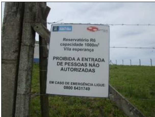
Figura 75: Placa indicativa do reservatório R6, localizado no bairro Vila Esperança.
