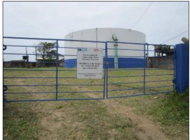
Figura 70: Portão de entrada e placa indicativa do Reservatório R4, localizado no bairro Divineia.
