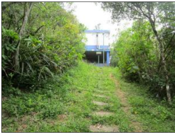
Figura 89: Via de acesso, a pé, ao reservatório R8, condições satisfatórias.
