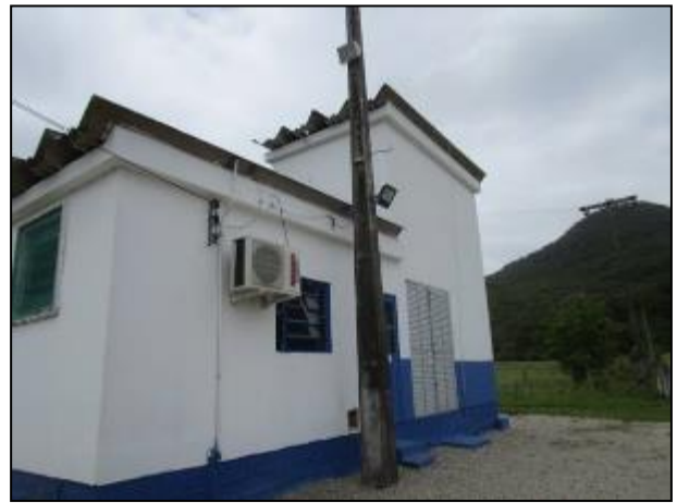
Figura 14: Vista da edificação onde estão o painel de controle e o monitoramento remoto das unidades.
