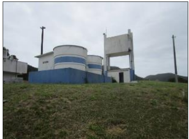
Figura 32: Reservatório R5 disponível na ETA Nova Brasília em boas condições.
