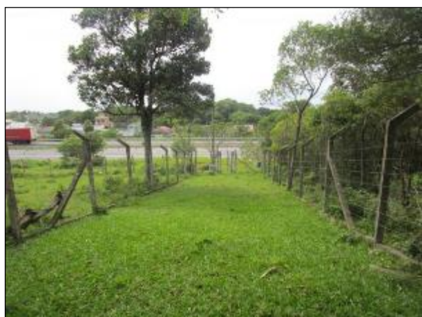
Figura 97: Caminho de acesso ao reservatório R9, boas condições com tempo bom, ao fundo a rodovia BR-101.
