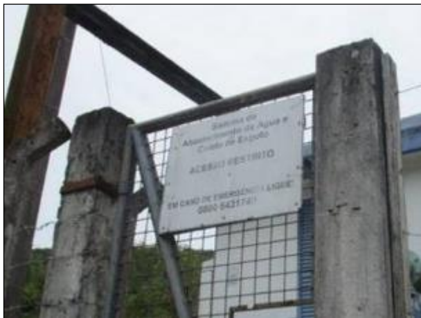
Figura 41: Placa esmaecida afixada no portão de entrada da unidade de recalque denominada ERAT 07, no bairro de Ibiraquera.
