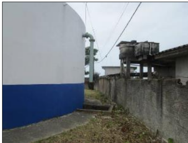
Figura 72: Vista da lateral do reservatório e do terreno, limpeza satisfatória no momento da visita ao local.
