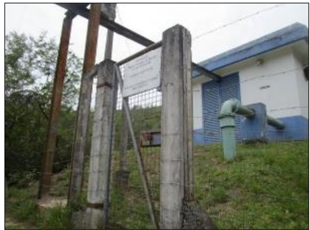
Figura 42: Vista do portão, fechado adequadamente, e estrutura frontal da unidade ERAT 07.
